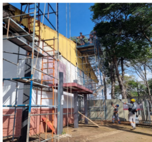
Substituição da cobertura do prédio do AC-SIARQ.
