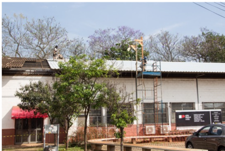
Substituição da cobertura (telhado)
