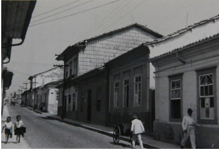
Fig. 122: Sobrado de taipa de pião com empena revestida com telhas, Itu-SP, [s. d.], C. B. Schmidt.
